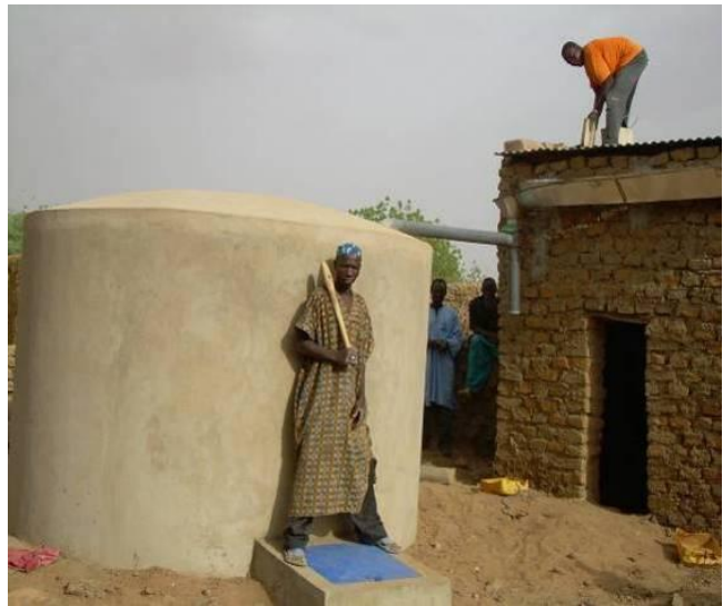
Photo 26: Impluvium en ferrociment
