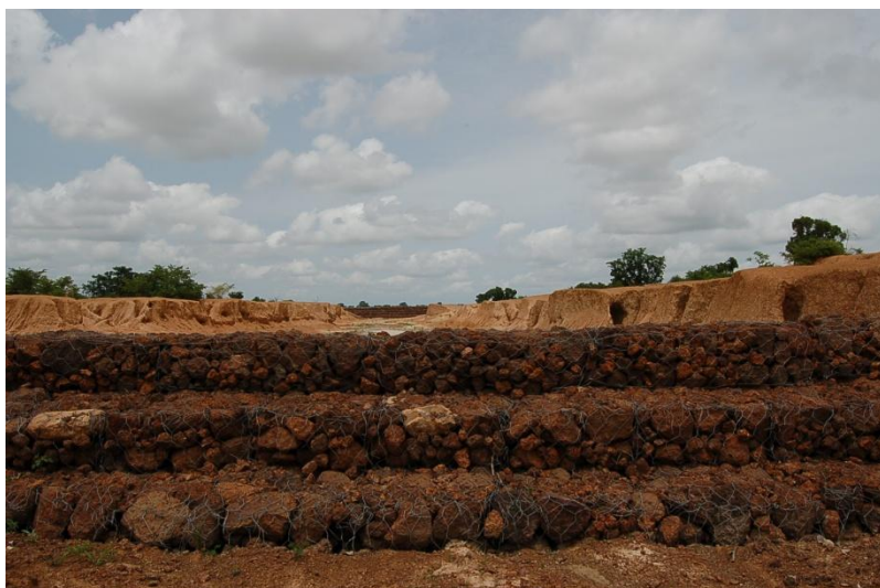
Photo 3 : Diguettes filtrantes au niveau d'une ravine
