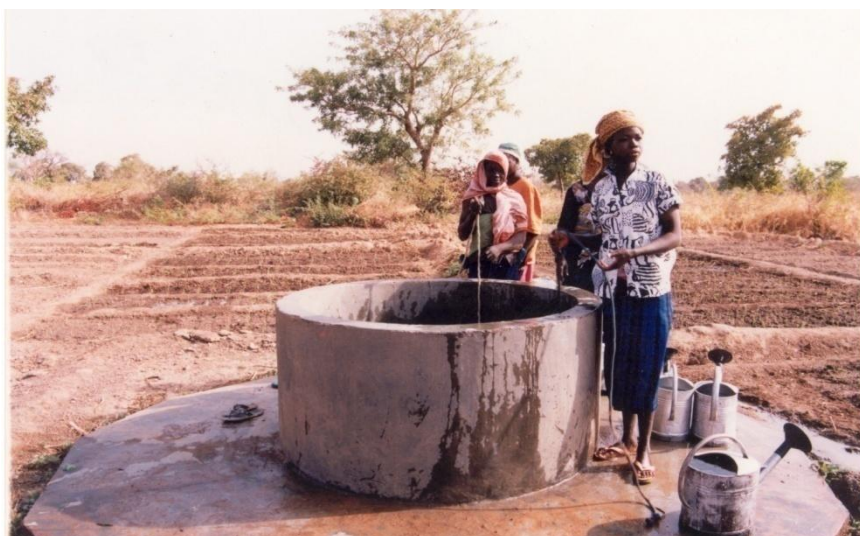
Photo 29: Puits à grand diamètre
