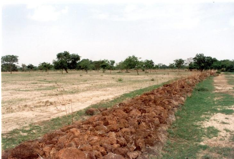
Photo 2 : Diguettes filtrantes à l'aval d'un champ
